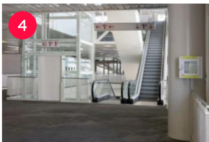
Halle 1.0, Zwischenboden zur Halle 3
